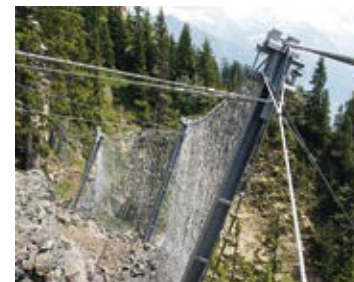
Steinschlagnetze oberhalb Bergwanderweg Schynige Platte–Breitlauenen.
