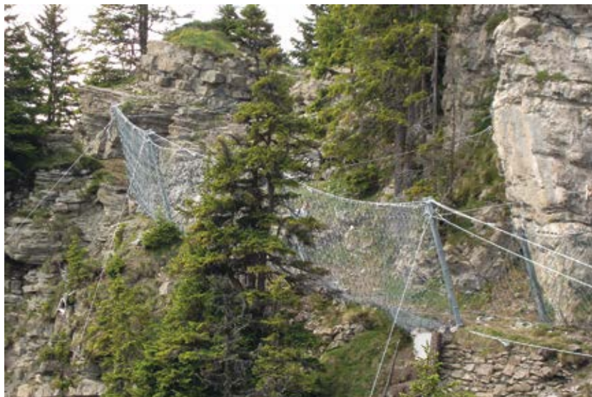
Steinschlagnetze oberhalb Bergwanderweg Schynige Platte–Breitlauenen.
