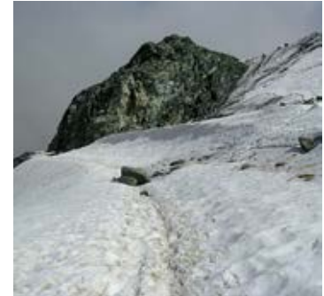
Brüchige Felspartie oberhalb des Alpinwanderweges zur Britanniahütte.
